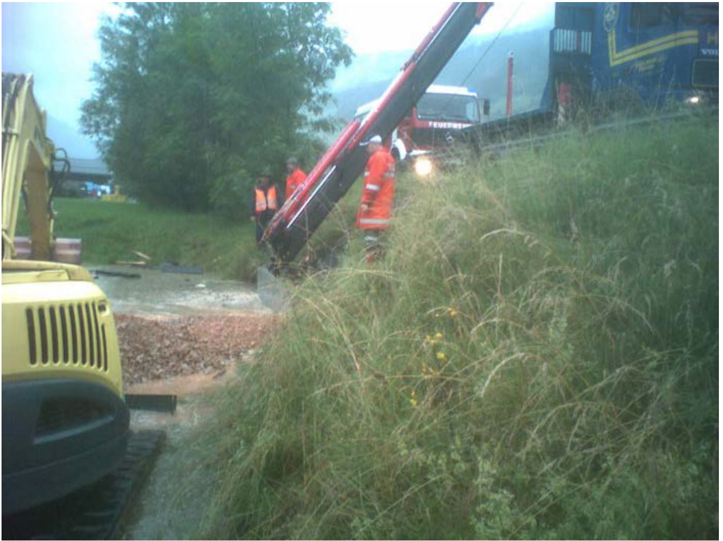
Hier musste die Wand die das Wasser abhielt, von einem Kran niedergehalten werden, da das Wasser begann, die Wand in die Höhe zu drücken
